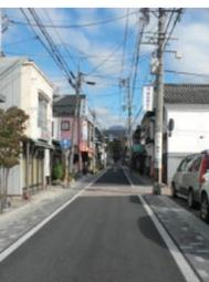
通りの入り口本町5丁目交差点から神社西鳥居近くまでの約300mの道路アスファルト舗装と側溝が整備されました。これは市の「思いやりの道づくり事業」の一環として実施されたもので、当初計画の電線類の地中化は実現しませんでした。が、歩車共存道路として安全性の確保が図られています。
